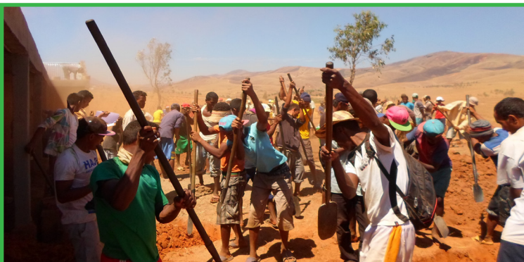
Aménagement du terrain par les bénéficiaires
