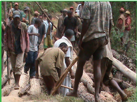
Participation de la communauté sous-forme de main d'œuvre
